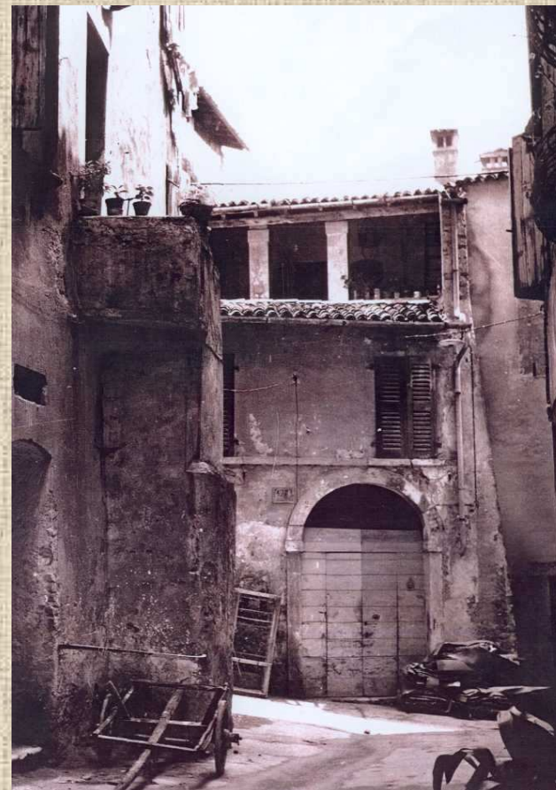
Piazzetta interna lungo vicolo Tomacelli a fine '800
